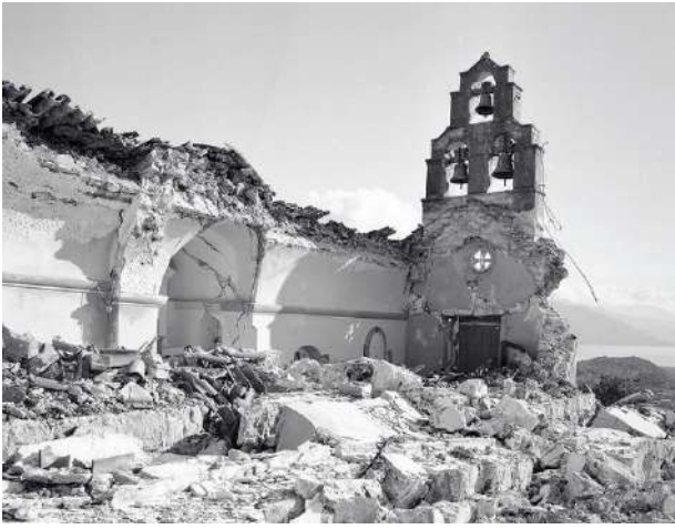
Разрушенная землетрясением церковь в Черногории в 1997 году
