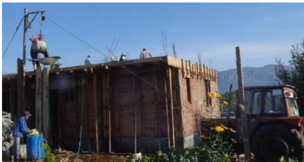
Начало строительства возле моего дома
